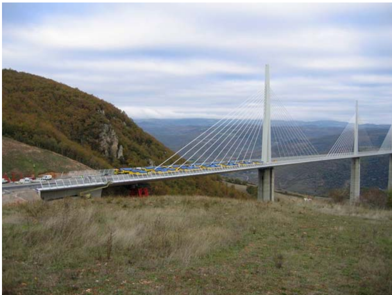
Photo 4: Chargement de la travée de rive, côté Sud
