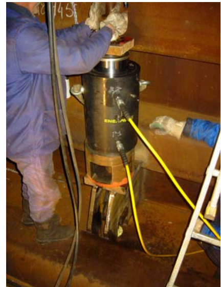
Vérin pour la mise en charge et ouvrier en n train de sectionner la barre avec un chalumeau.
