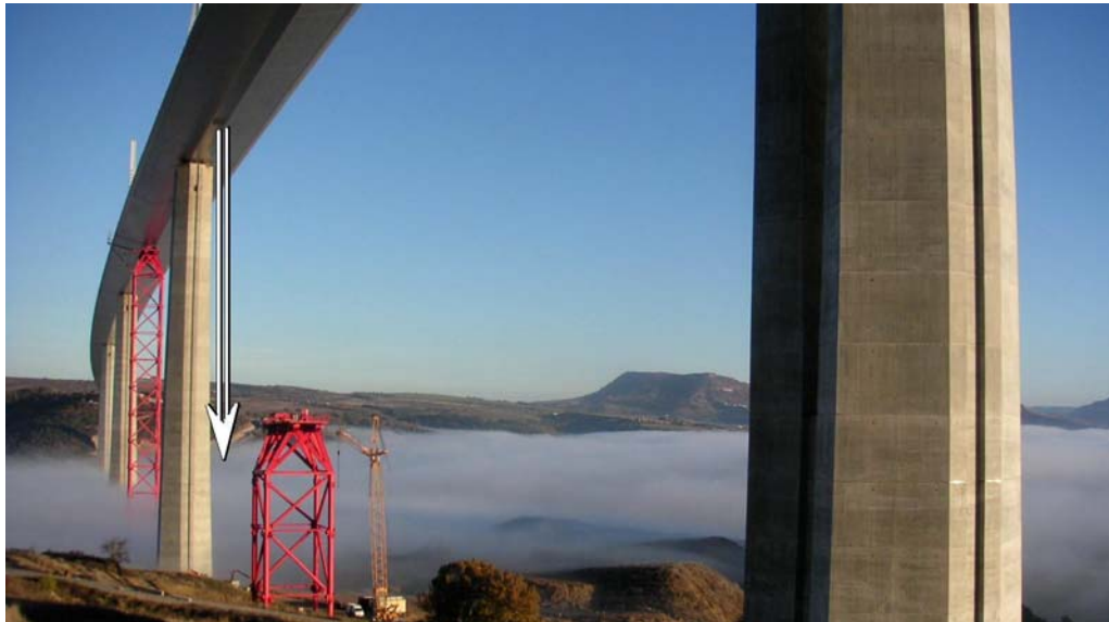
position du point d'ancrage du câble au tablier
