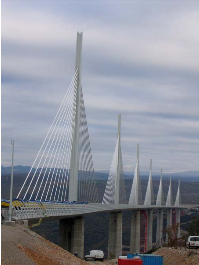
Photo 3: Déformée de l'ouvrage pendant les essais
