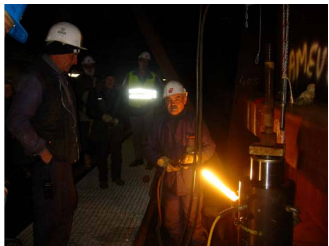
Photos 2: Dispositif d'ancrage de la charge au tablier
