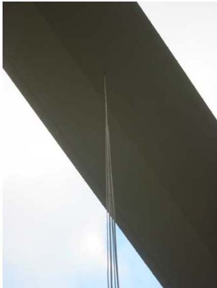
position du point d'ancrage du câble au tablier
